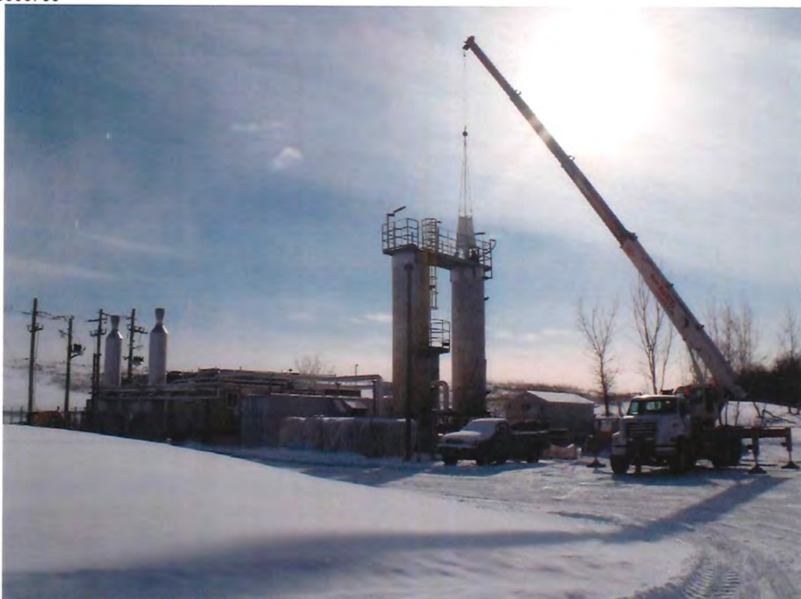
DSCF4077.jpg – Photo N°1 : Travaux de changement du media filtrant
