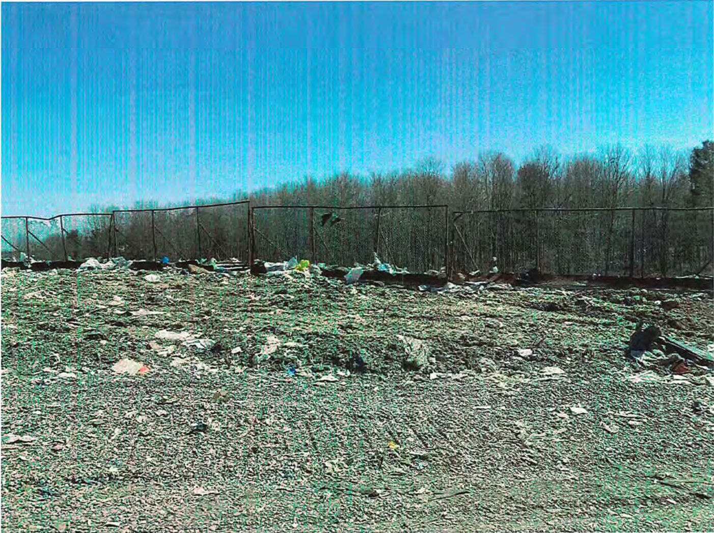
IMG_0360.JPG Photo 9. Barrières à proximité du front de déchet, afin de limiter l'éparpillement des déchets.
