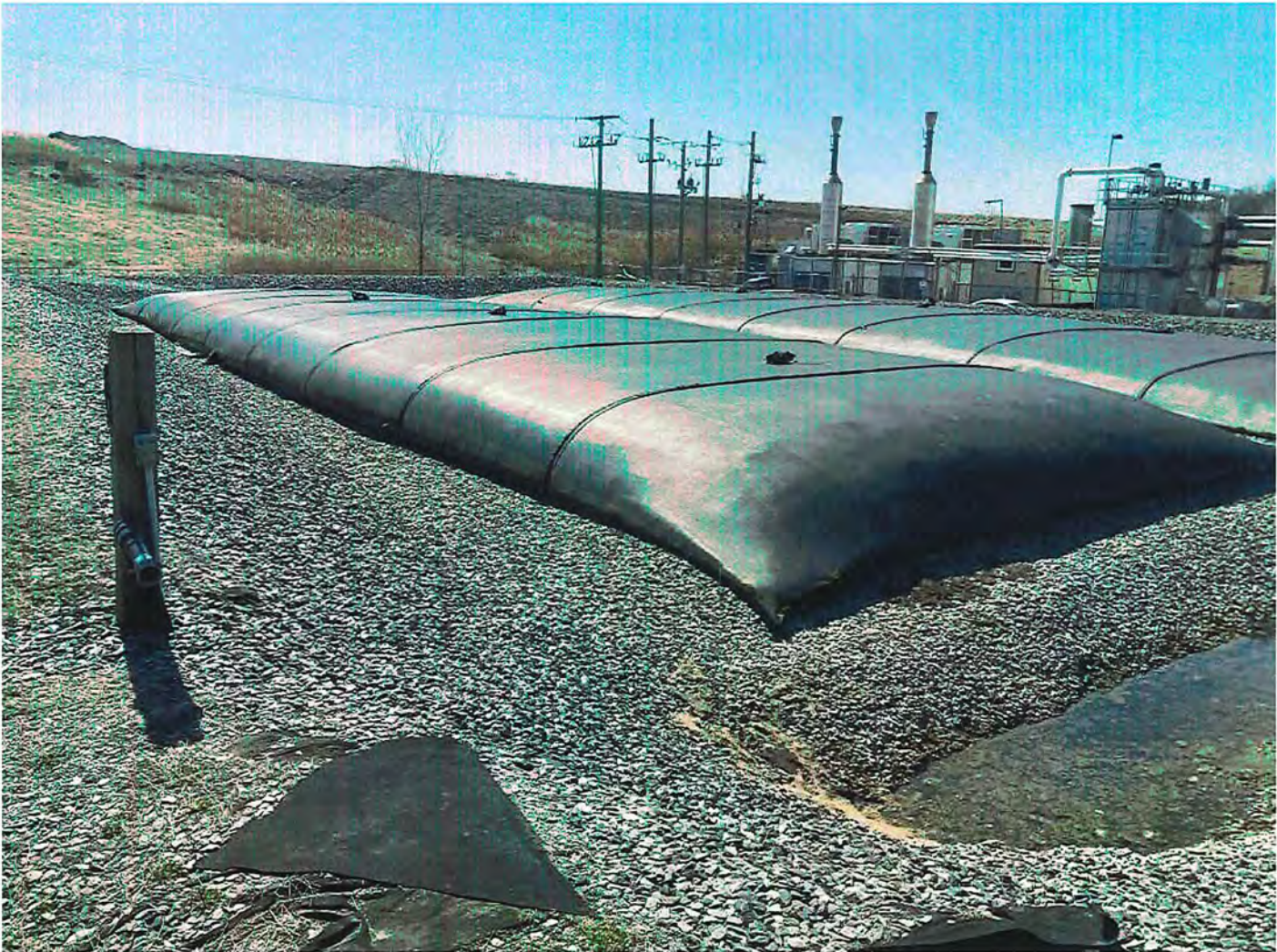
IMG_0352.JPG Photo 6. Géotubes contenant les boues de lixiviat sur le lieu d'assèchement.
