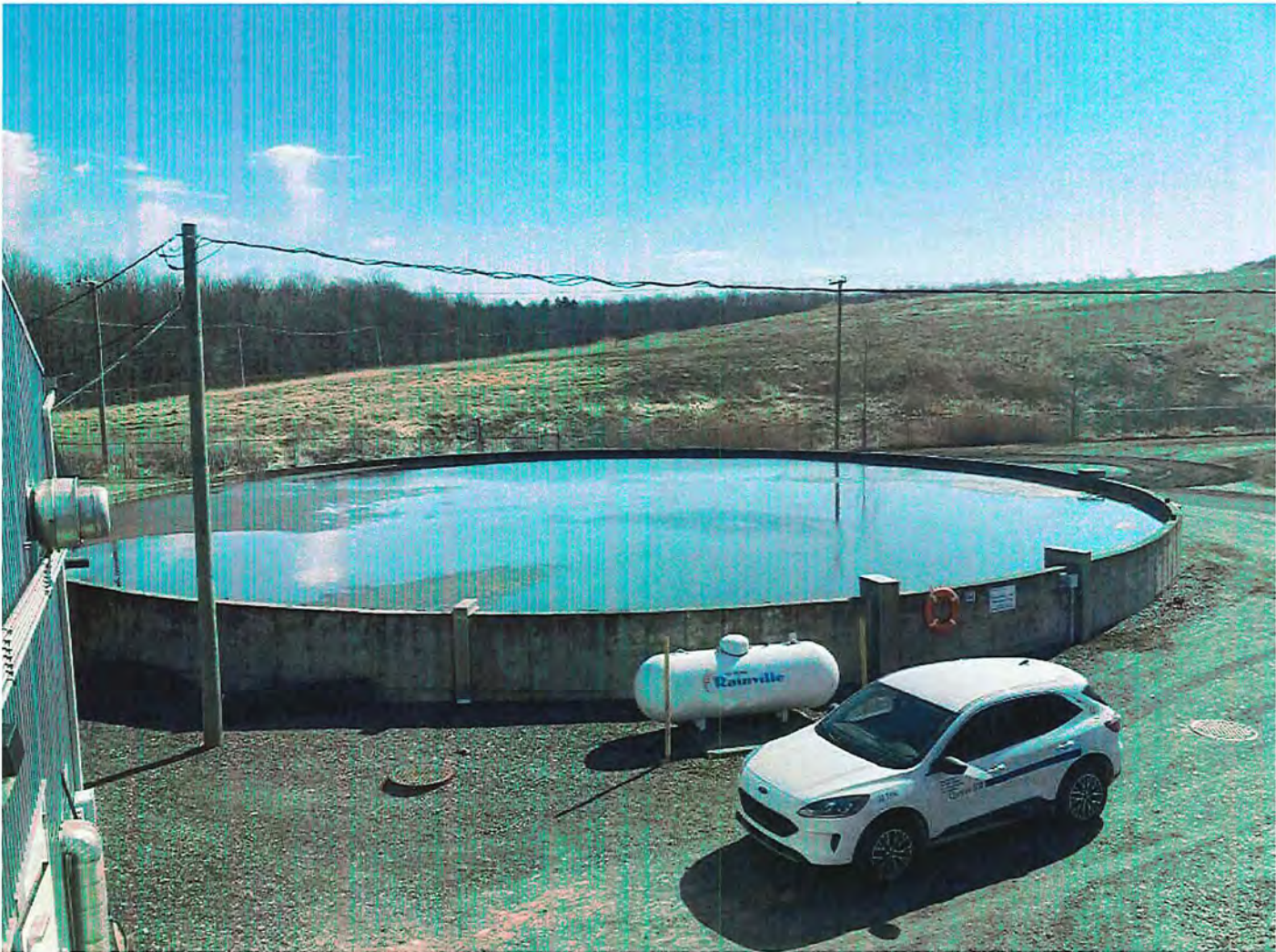
IMG_0342.JPG Photo 3. Bassin d'accumulation des boues du traitement du lixiviat.
