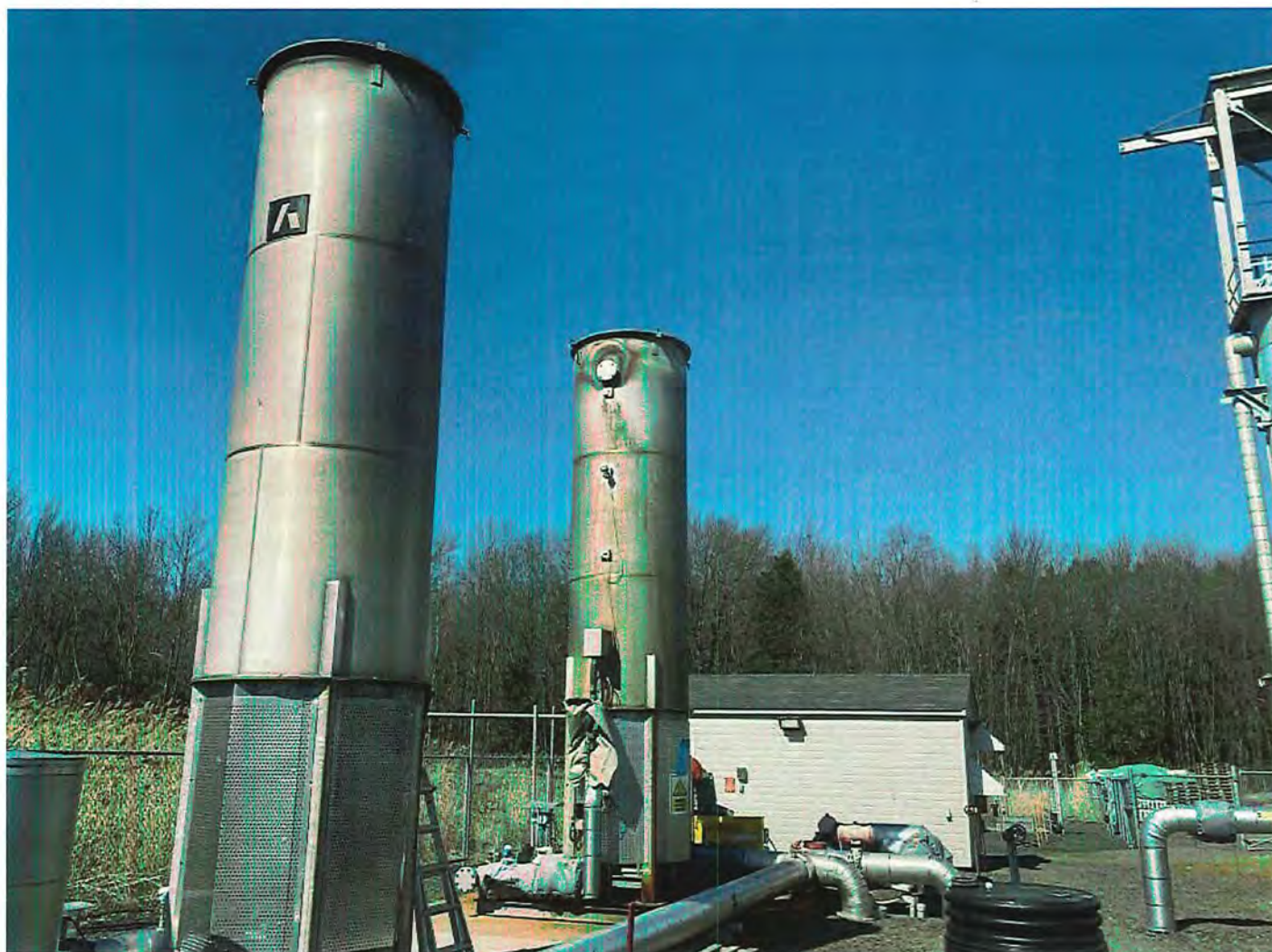
Photo 5. Torchères présentent sur le site qui sont en soutien aux réacteurs
