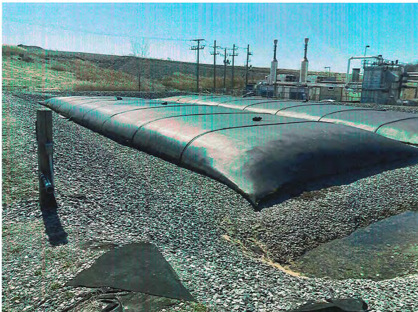
Photo 6. Géotubes contenant les boues de lixiviat sur le lieu d'assèchement.
