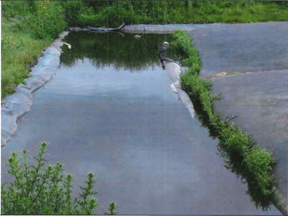
DSCF5813.jpg Photo N°3: Filtrant accumulé gravitairement du côté ouest du bassin
